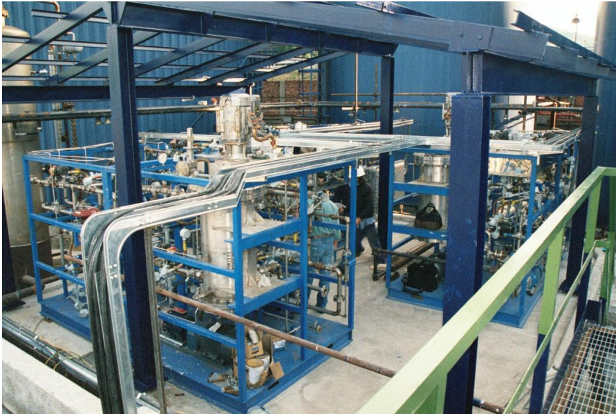
Unidades Para Doe Con Capacidad De 300 Gpm Refinería Iplom, Italia
